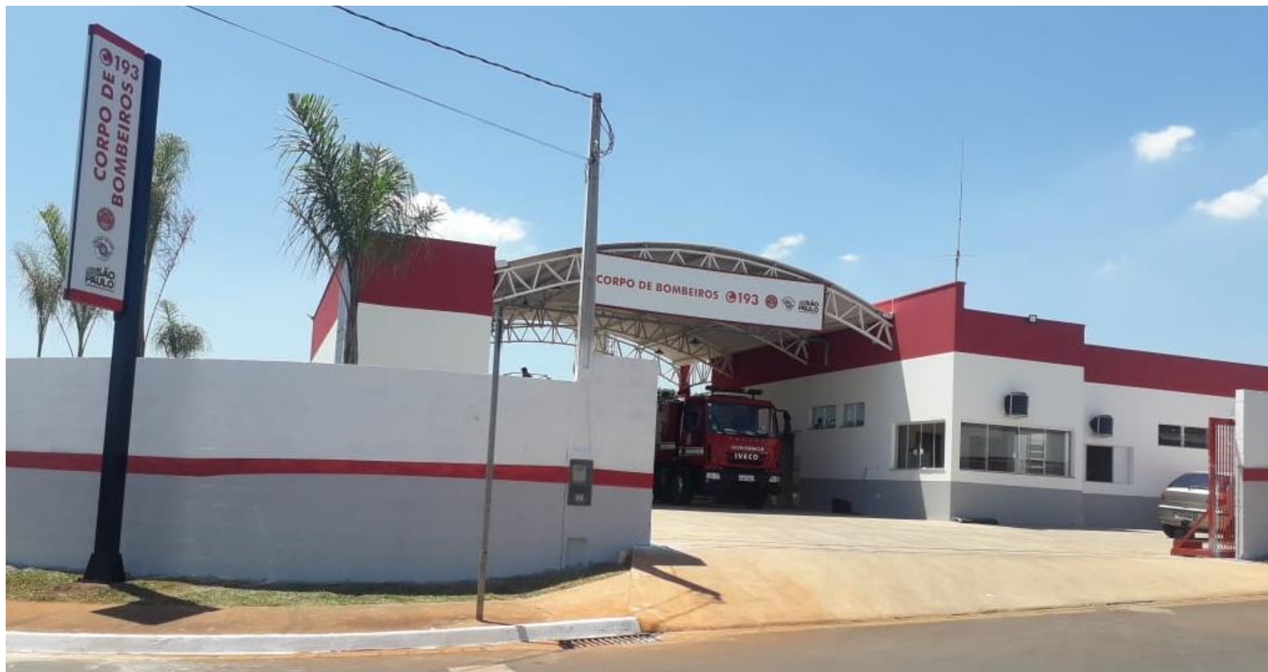
Foto de identificação visual de fachada
