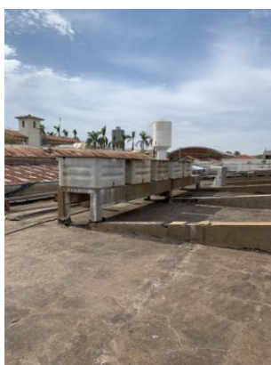
Foto 5 base de concreto 1
