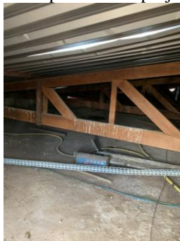
Foto 3- Parte do telhado que será removido inclusive estrutura madeira
