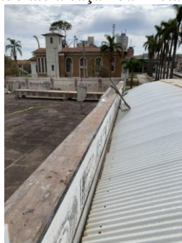
Foto 7 retirada de calhas e rufos
