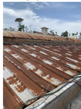
Foto 2- telhas metálicas a retirar
