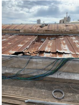
Foto 1- telhas metálicas a retirar
