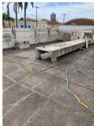
Foto 6- base de concreto 2
