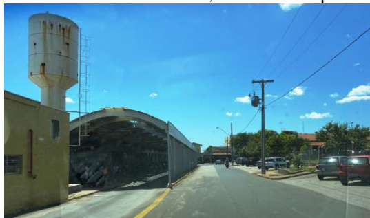
Foto 8 Vista do reservatório metálico
