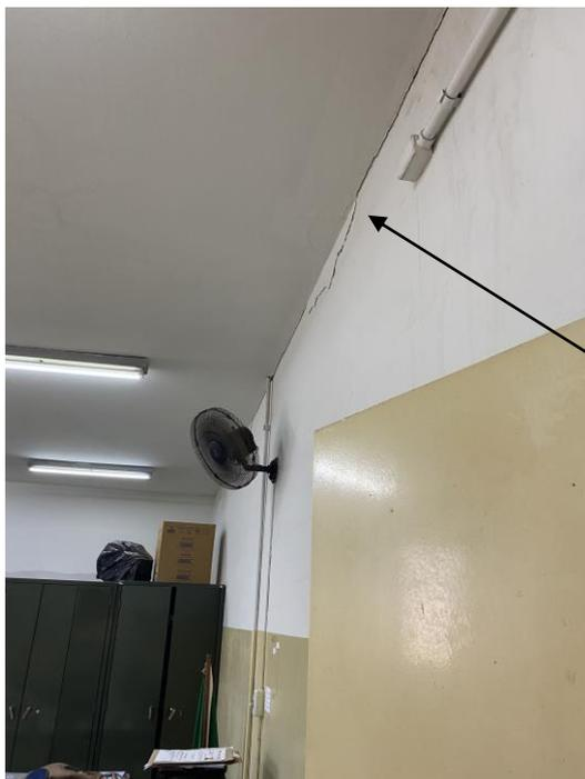
Trinca e fissura entre a laje e parede Sala dos Professores
