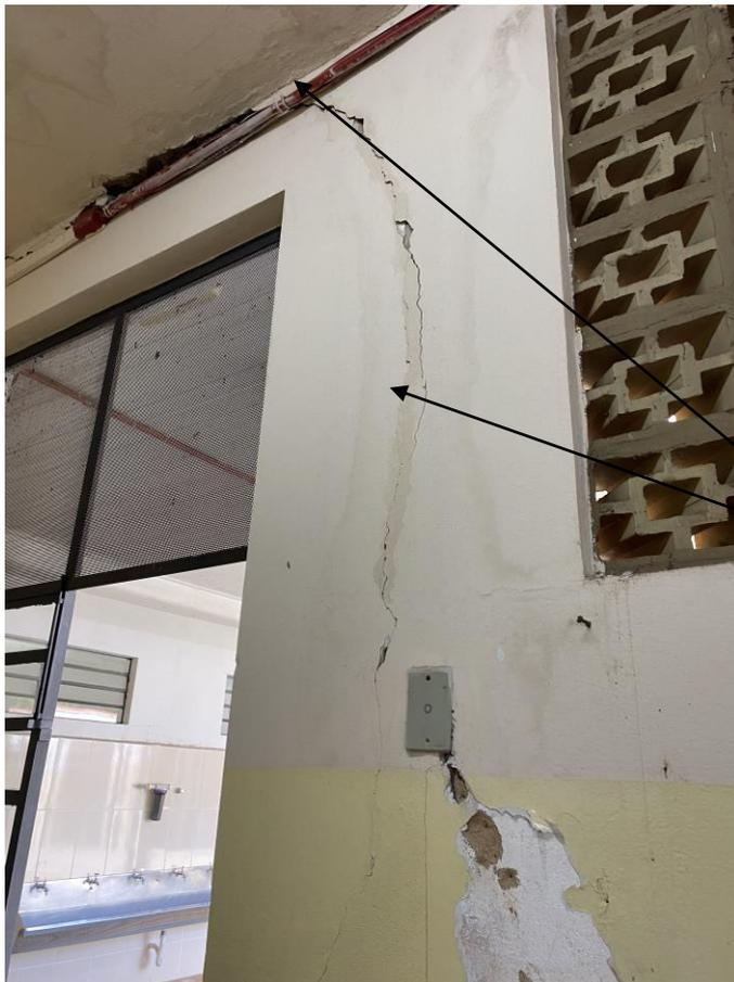
Trinca e fissura entre a laje e parede Saguão de Entrada
