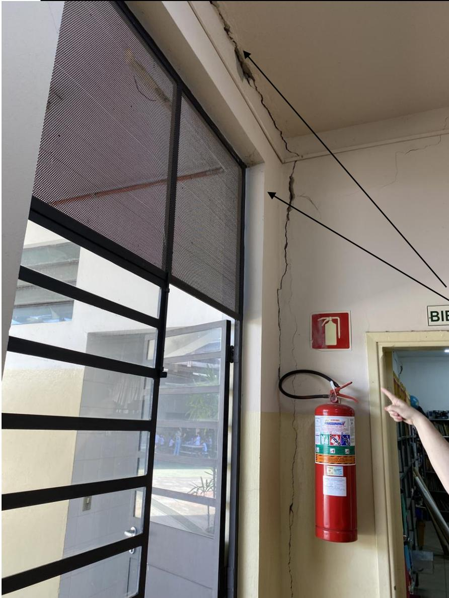
Trincas e fissuras laje e paredes no Saguão de Entrada
