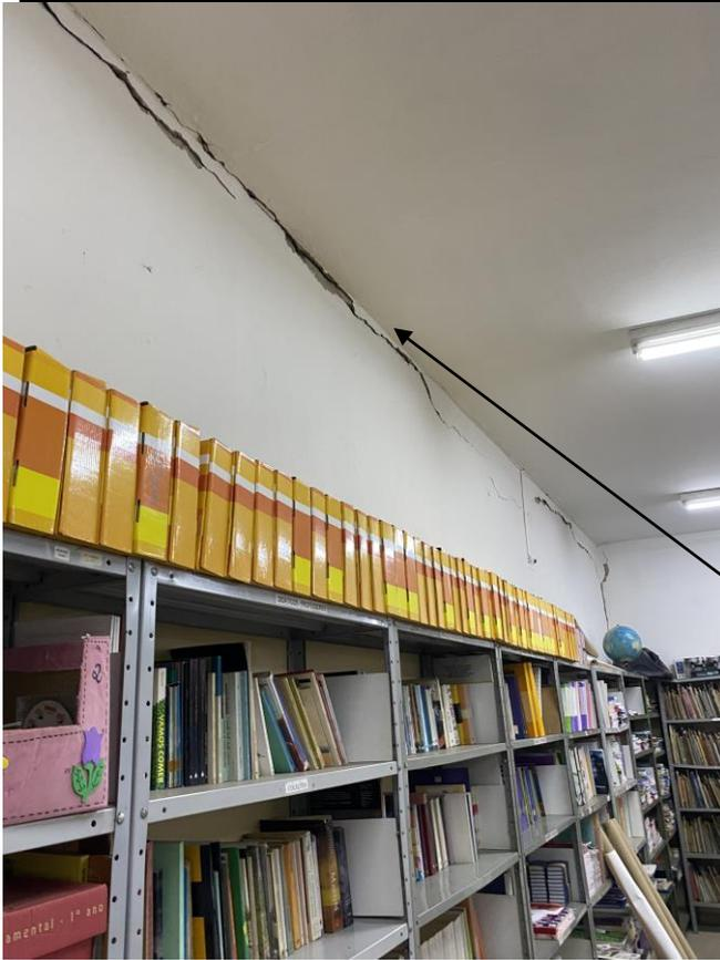
Trincas e fissuras laje e paredes na Biblioteca
